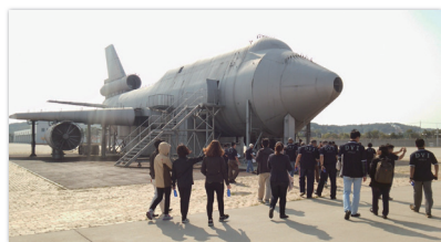
災害訓練の様子2 航空機事故の訓練。事故機に見立てた航空機型建築物で機体の炎上も再現できる (2014年インチョン空港)
