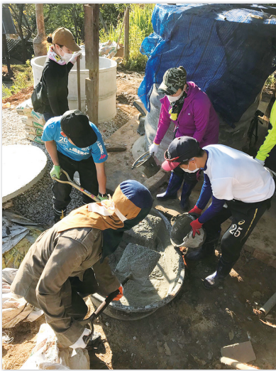
村人と協力し 貯水槽増設作業を行う
